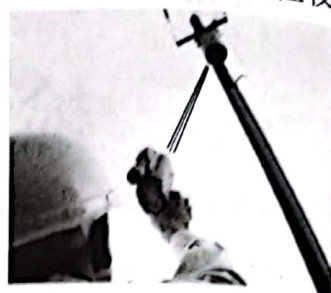
图1-2 利用红外线辐射成像仪测量供电变压器的表面温度
